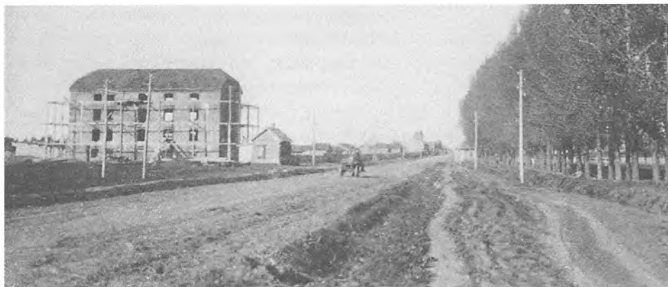
Строительство мельницы Кошкина в Восточной слободе. Фото 1910-х гг.
